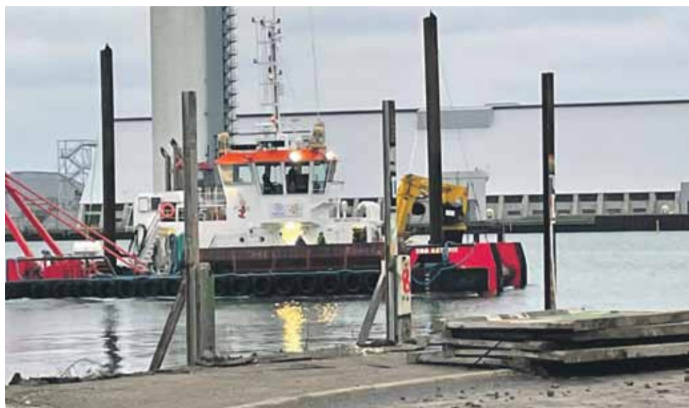
Nu er rækværket ud mod Øresund fjernet på Refshalevej ved tørdokken. Tørdokken ender med at blive lukket, når vejen til jordtransport bliver etableret ud for Refshaleøen. Tørdokken er et kulturminde og en af de største eksisterende tørdokke i verden. Det er snart slut. Henning
