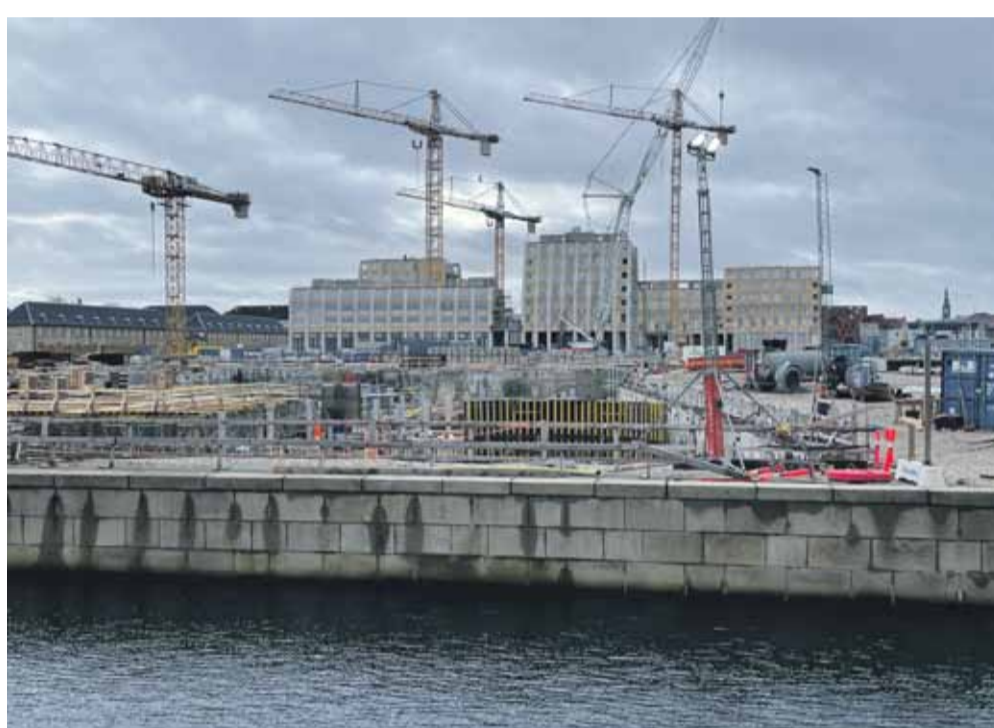
På Dokøen bygges der under jorden, hvor der skal laves en parkeringskælder i 2 etager. Det bliver spændende at se, hvad Maerskfonden beslutter at lave på den eksisterende parkeringsplads på den anden side af operaen. I henhold til lokalplaner kan der bygges en boligblok. Henning
